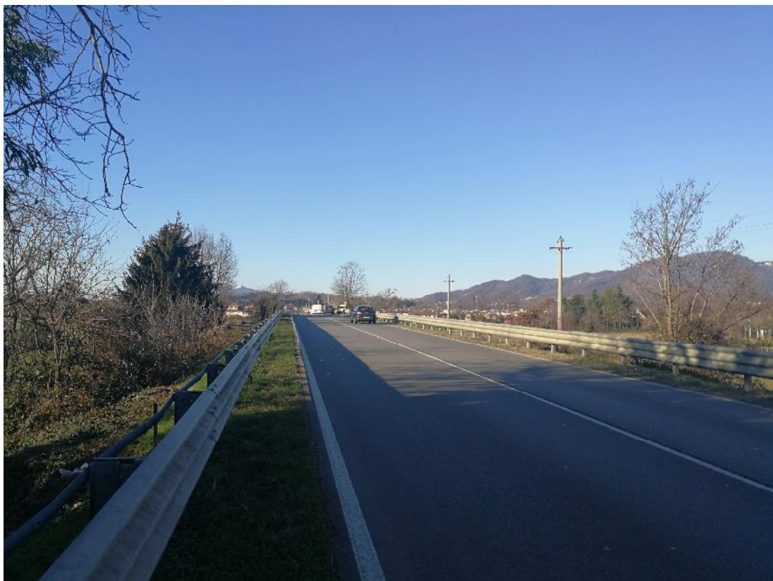
Foto n. 1 – Vista SP 170 in direzione Calusco d'Adda
