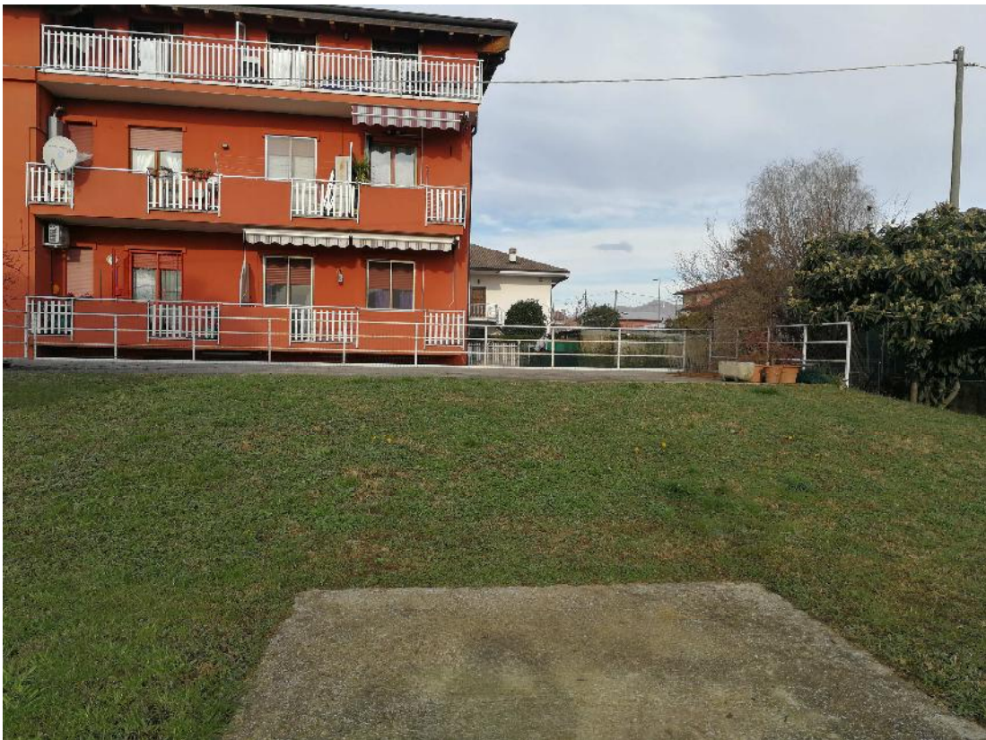
Foto n. 35 – Vista autorimessa seminterrata
