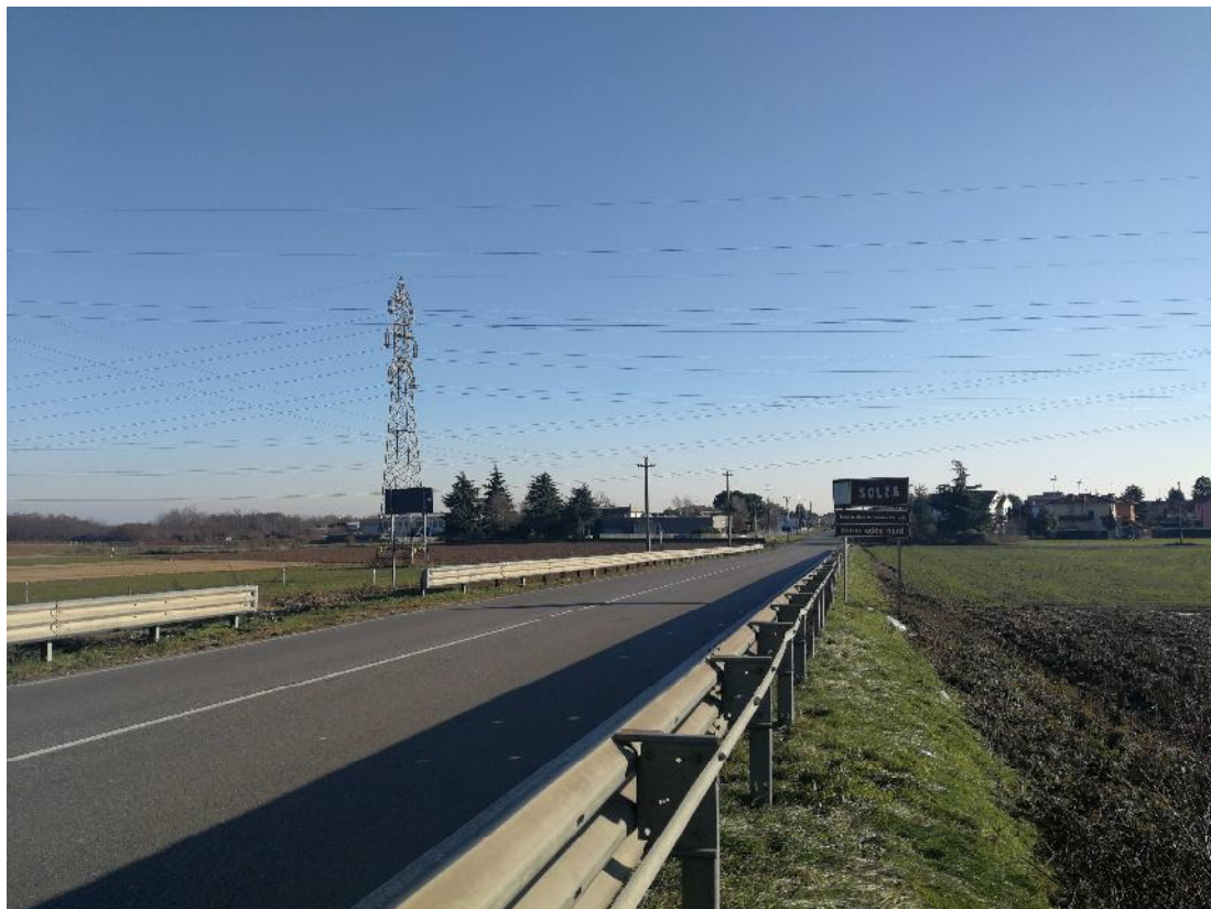
Foto n. 8 - Vista SP 170 direzione Solza - Scarpata
