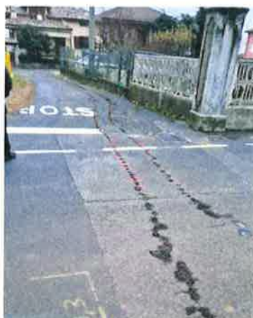
Tracciamento scavi su via delle Brughiere
