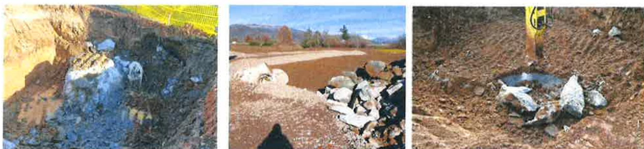
Manufatto in cls di contrasto tubazione vetroresina Consorzio di Bonifica
