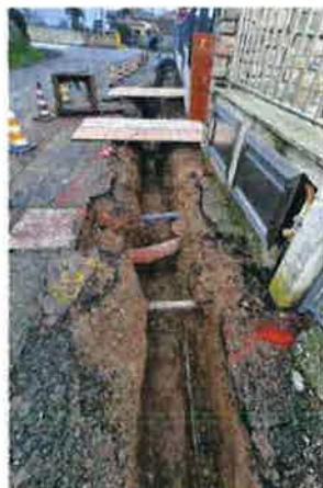
Scavi e ripristini tubazioni UNIACQUE via delle Brughiere
