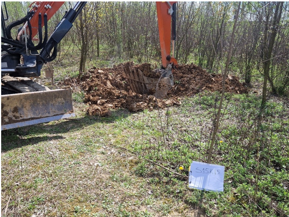
Esempio di fase di scavo S15
