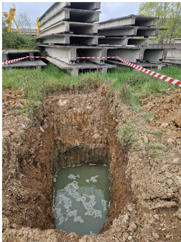
Scavo S4 con venute di acqua livello stabile a 1.90 cm da p.c.
