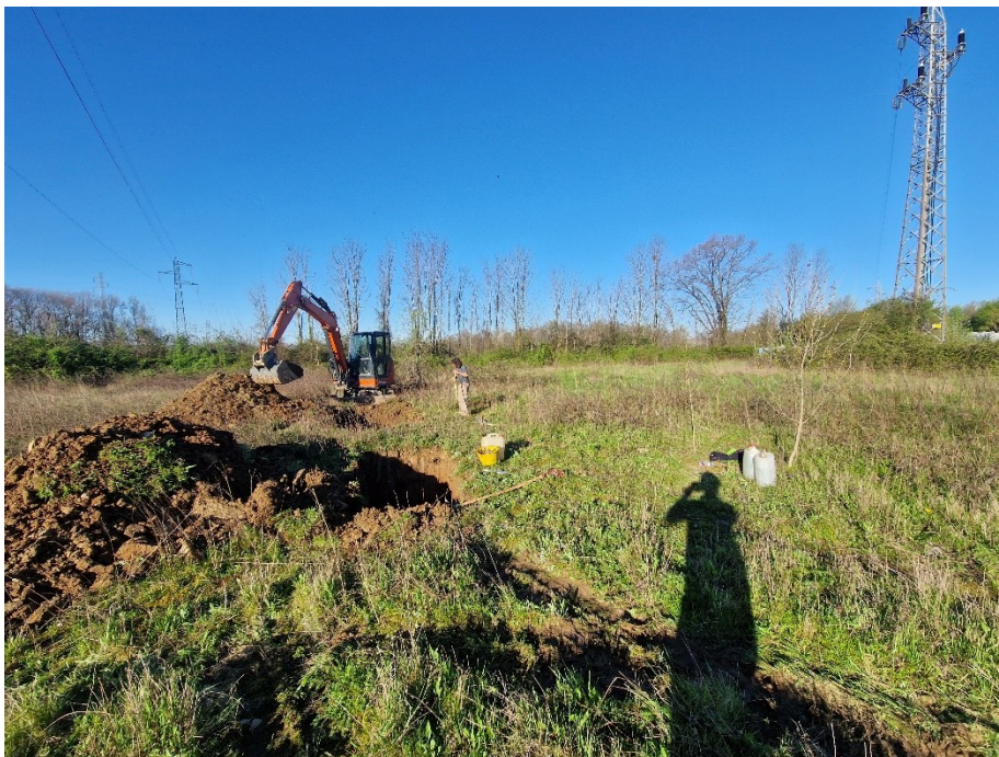
Esempio fasi di scavo in S2
