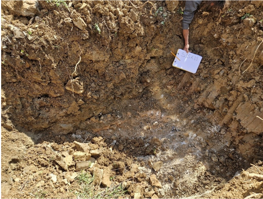
Scavo S15 interrotto per presenza di materiali cementati (forse vecchia strada)
