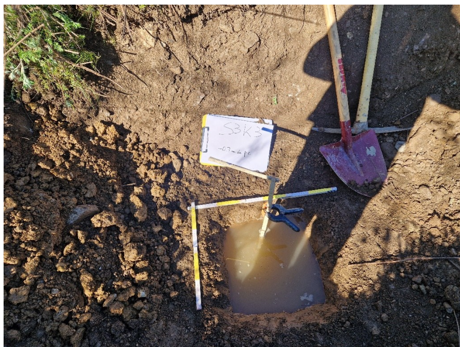
Esecuzione prova K3 in S3
