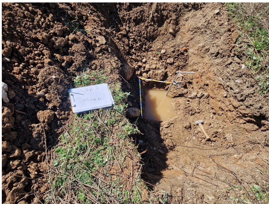
Esecuzione prova K7 in S7
