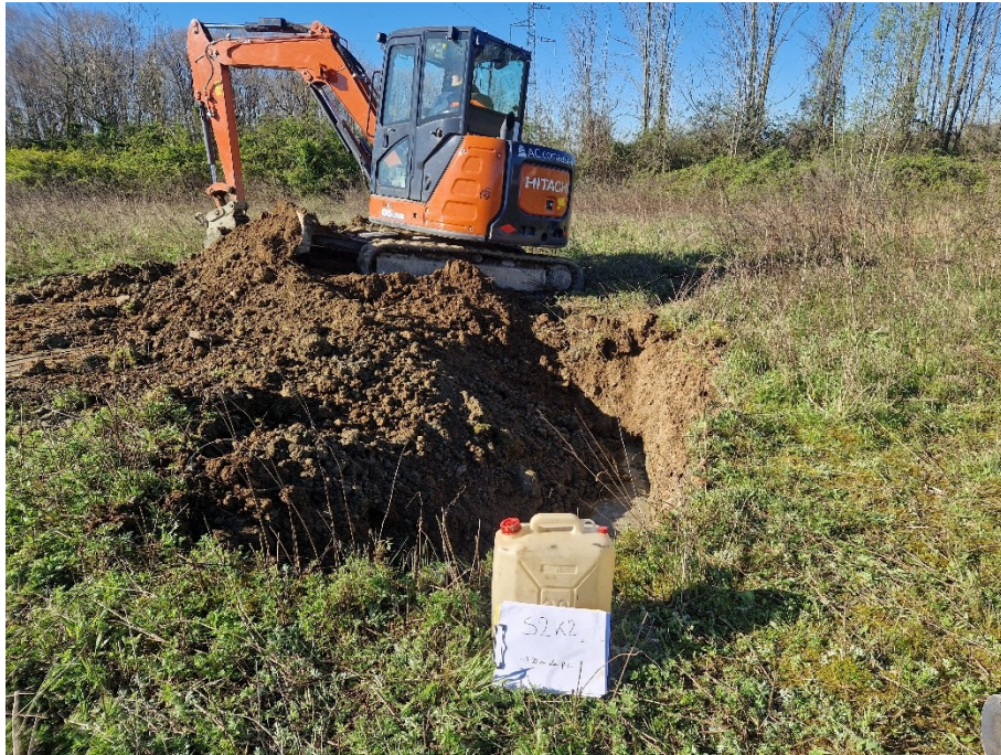
Fase di scavo in posizione K2
