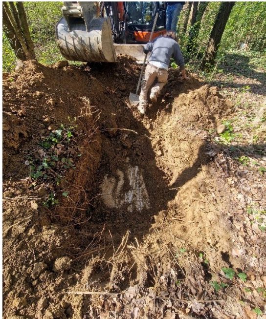
Prefabbricati sotterrati a circa 1.0 m (S13) AREA B
