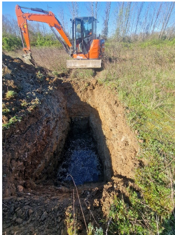
Fase di scavo in posizione K2 con venuta di acqua stabile a 1.9 m da p.c.
